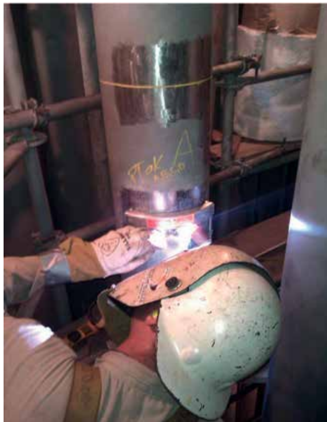
Подготовленный специалист устанавливает датчик
