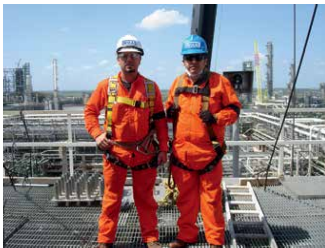
Группа монтажа на объекте
